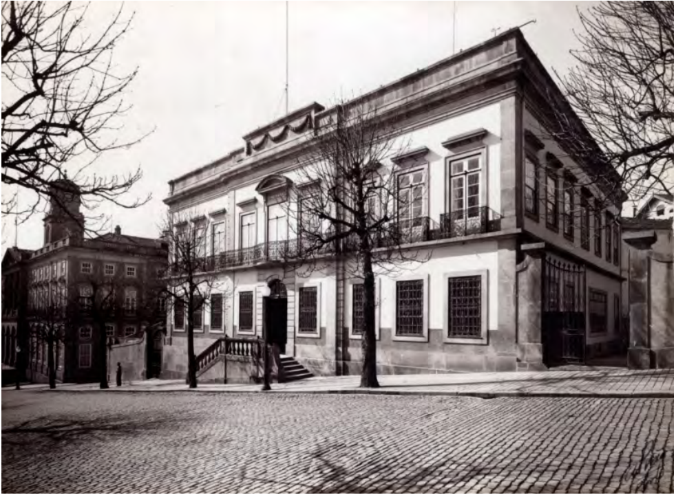
Fig. 1 – O edifício da sede do Banco Comercial do Porto aquando da compra pelo IVP (foto de Álvaro Cardoso de Azevedo (Casa Alvão) Coleção do Instituto dos Vinhos do Douro e Porto, I).
